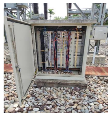
Gambar 2. 8 Marshalling Kiosk
