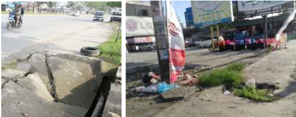
Gambar 4. Trotoar Rusak, Kotor Dan Berubah Fungsi Menjadi Tempat Pembuangan Sampah
