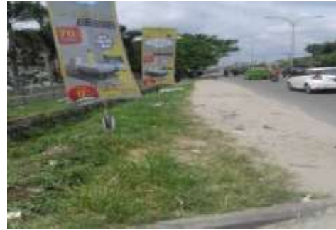
Gambar 2. Trotoar Tidak Berkesinambungan
