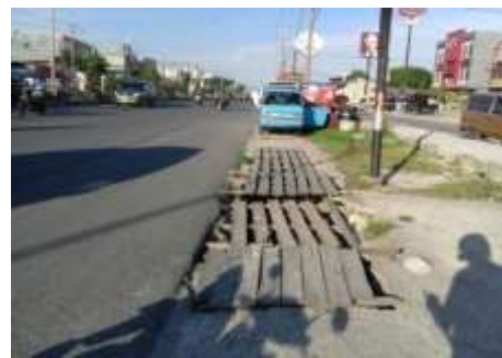
Gambar 3. Trotoar Tidak Dibuat Dari Material Yang Layak
