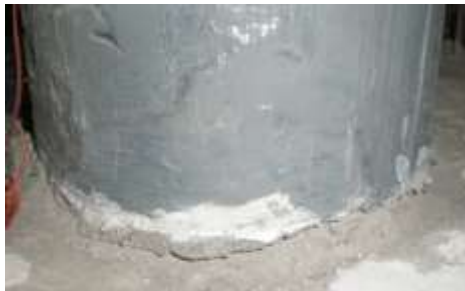
Gambar 9. Pola Retak Kolom Perkuatan
