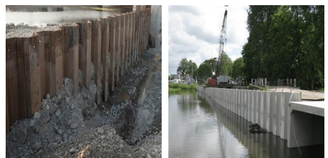
Gambar 3. Perkuatan Sheet Pile
