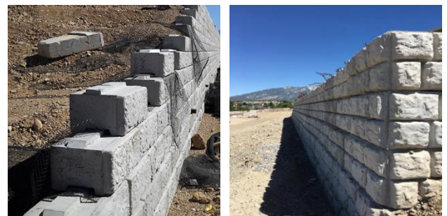
Gambar 2. Perkuatan Blok Beton
