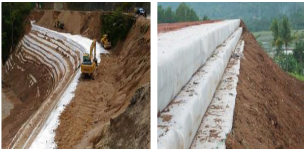
Gambar 5. Perkuatan Geotekstil
