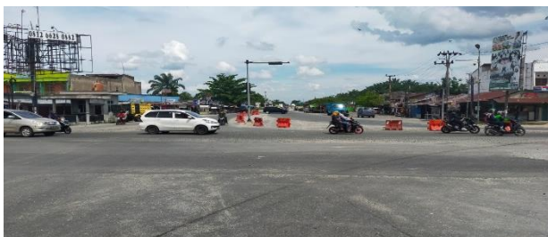
Gambar 3. Kondisi Eksisting Jalan Kubang Raya
