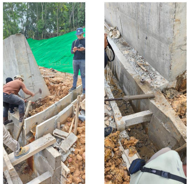
Gambar 3. Penyelidikan Tanah dikaki Lereng
