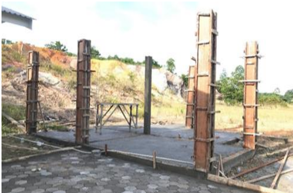
Gambar 3. Pekerjaan Kolom dan Balok (Struktur Atas)
