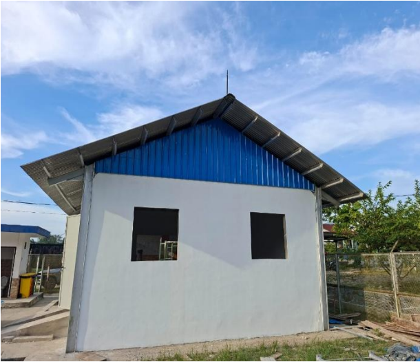
Gambar 4. Kondisi bangunan TPS Limbah B3 setelah pekerjaan konstruksi utama selesai.
