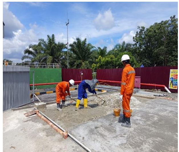
Gambar 2. Pelaksanaan pekerjaan lantai sebagai elemen awal sistem containment TPS Limbah B3
