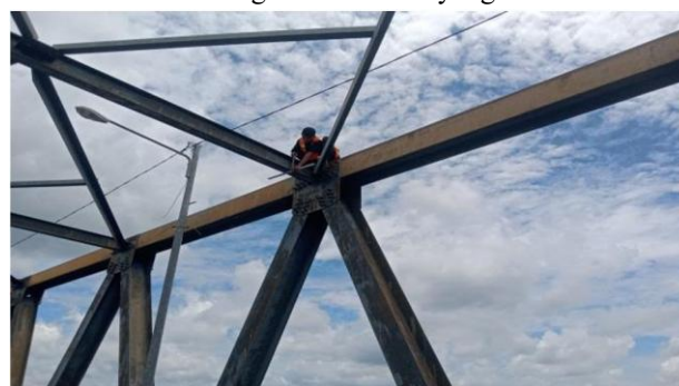
Gambar 9. Pengukuran Dimensi Rangka Atas (Sumber: Dokumentasi lapangan)
