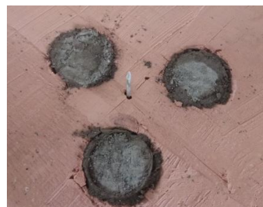
Gambar 6. Kolom Campuran Fly Ash dan Bottom Ash Pemasangan kolom dilakukan dalam beberapa tahapan sebagai berikut :
