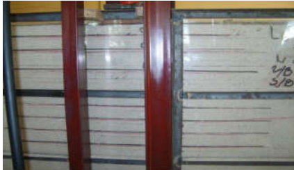
Gambar 6. Kondisi Sebelum Pembebanan
