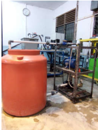
Gambar 3. Alat uji rangkaian pompa
